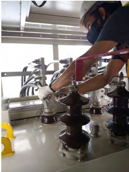
Photo 5-6-7-8-9-10 : ภาพแสดงการตรวจสอบและทำความสะอาดของหม้อแปลง, การทดสอบ Insulation Resistance ของหม้อแปลงขณะทำ Preventive Maintenance
