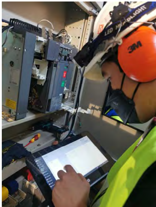
Photo 11-12-13-14-15 : ภาพแสดงการทำความสะอาดและ ทำการทดสอบ Trip unit, Contact Resistance ของ Air Circuit Breaker
